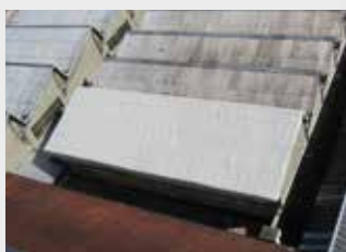
Pose de bâche sur couverture sinistrée
